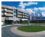
© Falkensteiner Hotels & Residences und Firmen der PHO Waasenstraße 1-3
